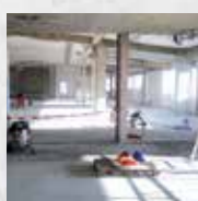
Sanierung von Stützen
