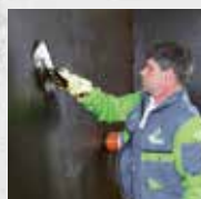
Abdichtung gegen Radon
