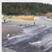
Abdichtung von Bodenplatten
