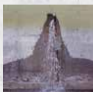
für wasserführende Risse
